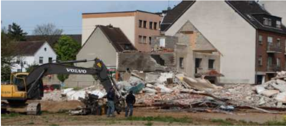
Auch das letzte Haus auf dem Areal im Zentrum von Niederkassel ist nun abgerissen worden. Foto: Stefan Villinger
