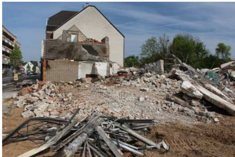
Auf dem Gelände sollen unter anderem ein Lebensmittel- und ein Drogeriemarkt entstehen. Foto: Stefan Villinger
