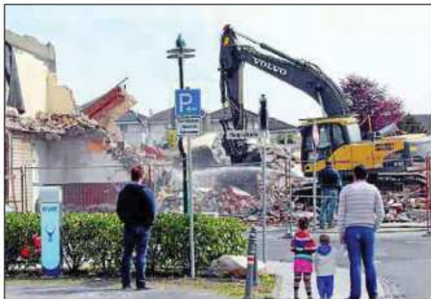
Ein Bagger reißt an der Niederkasseler Hauptstraße Häuser ab, die einem lange geplanten Einkaufcenter weichen müssen.
