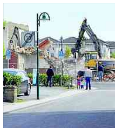
Im April rissen Bagger die verbliebenen Häuser ab. FOTO: MARTINA WELT
