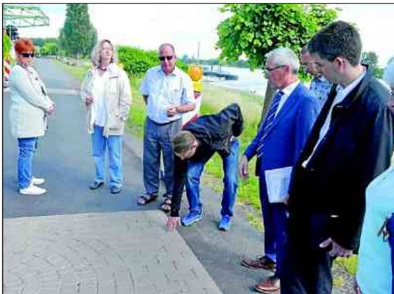
Der Bauausschuss macht sich ein Bild vor Ort: Der Bodenbelag sieht aus Pflaster, ist aber Asphalt mit einer eingestanzten Prägung.
