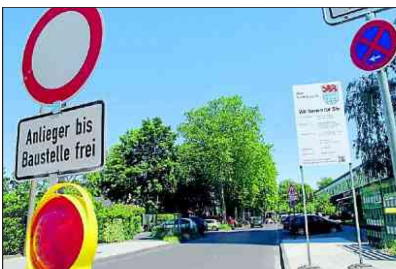
Die Kanalsanierung führt zu Einschränkungen in Menden. FOTO: LEHNBERG
