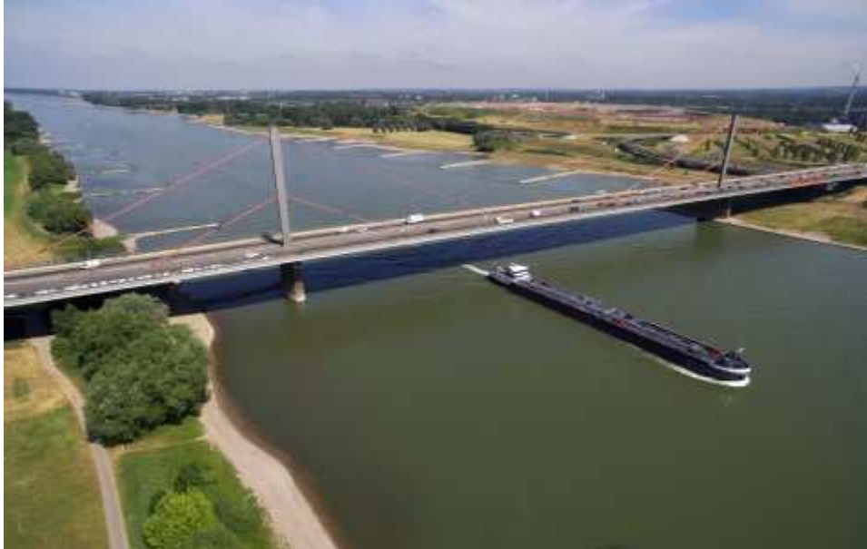
Die Leverkusener Brücke wird 2017 erneuert – gibt es dann eine weitere Rhein-Querung? Foto: dpa
